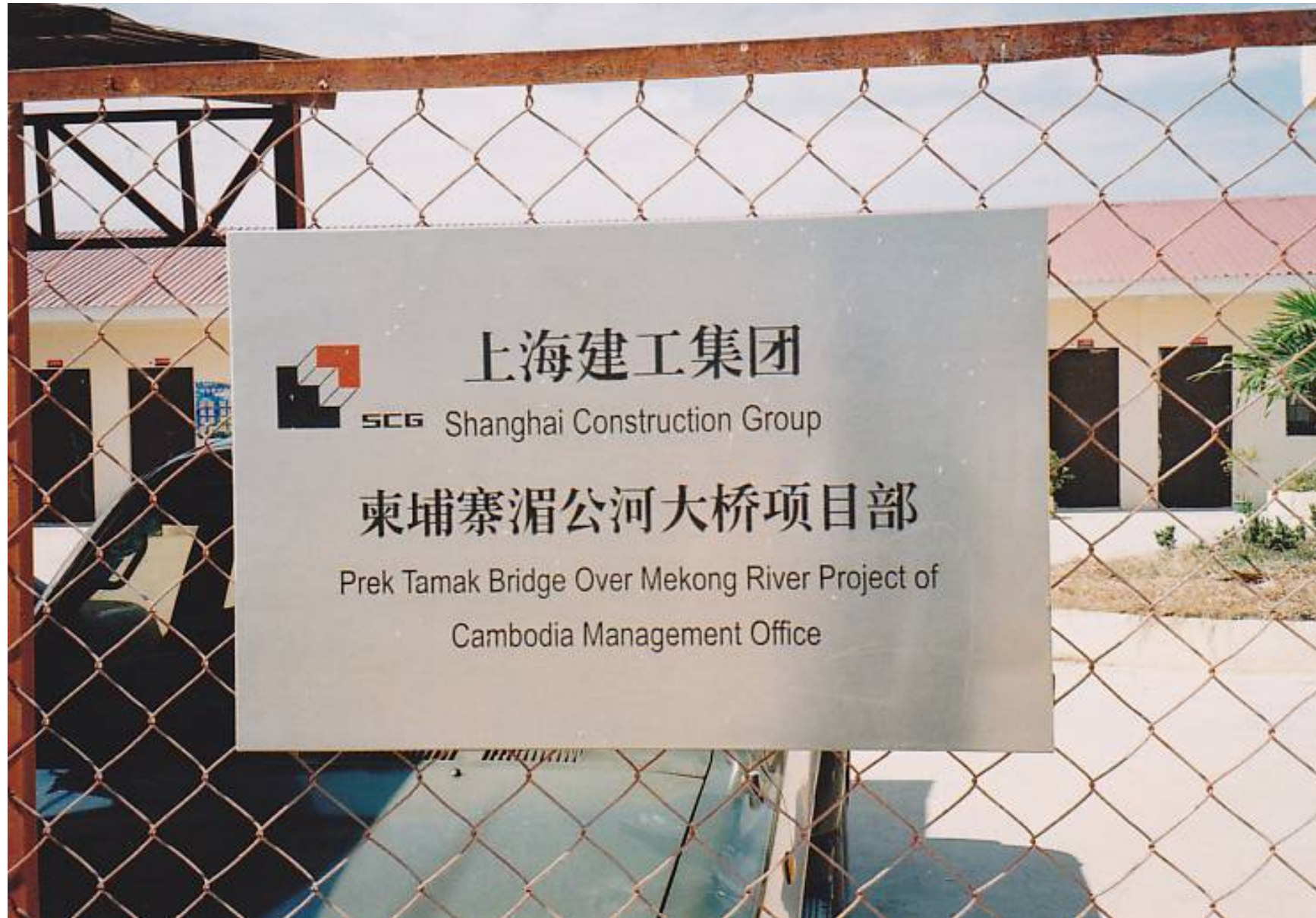
中国の援助による橋梁建設現場で(プノンペン郊外)
